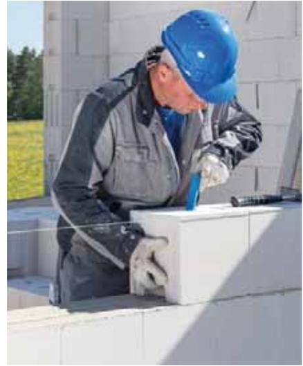
Bild 4 Versetzen von KS -R-Plansteinen in Dünnbettmörtel
