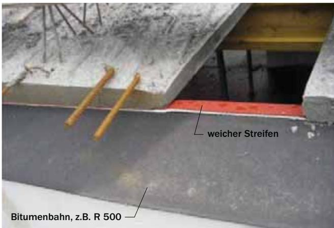
Bild 30 Beispiel für Einlage weicher Streifen und Bitumenbahnen
