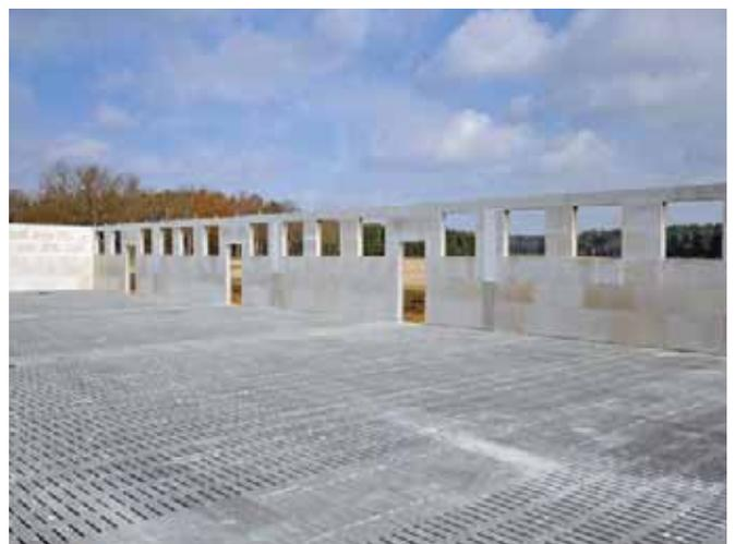
Bild 49 Rohbau eines Maststalls
