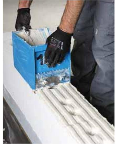
**Bild 39** Auftragen des Mörtels für die Lagerfuge
