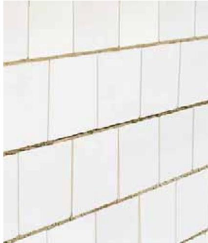
Bild 20 KS -R-Blocksteine für Normalmauermörtel
