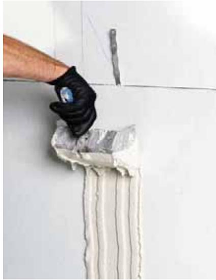
**Bild 38** Mörtel für Anschlussfuge auftragen
