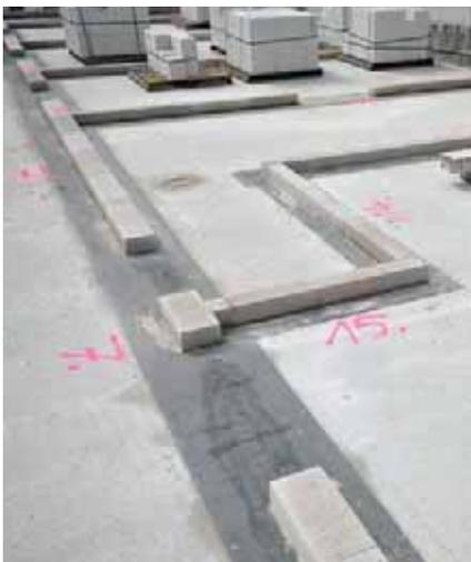
Bild 22 Anlegen der Kimmerschicht
