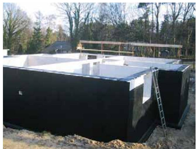
Bild 6 Kellerwand-Außenseite mit PMBC-Abdichtung
