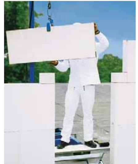
**Bild 28** KS-Fertigteilstürze für großformatiges Mauerwerk
