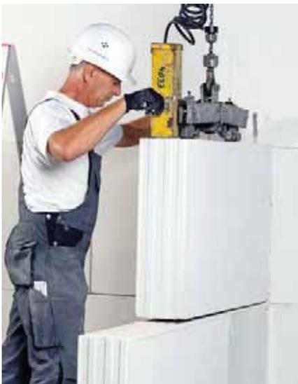
**Bild 40** Versetzen eines XL-Elements
