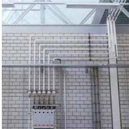
**Bild 2** Innensichtmauerwerk aus Kalksandstein mit befestigten Installationsleitungen
