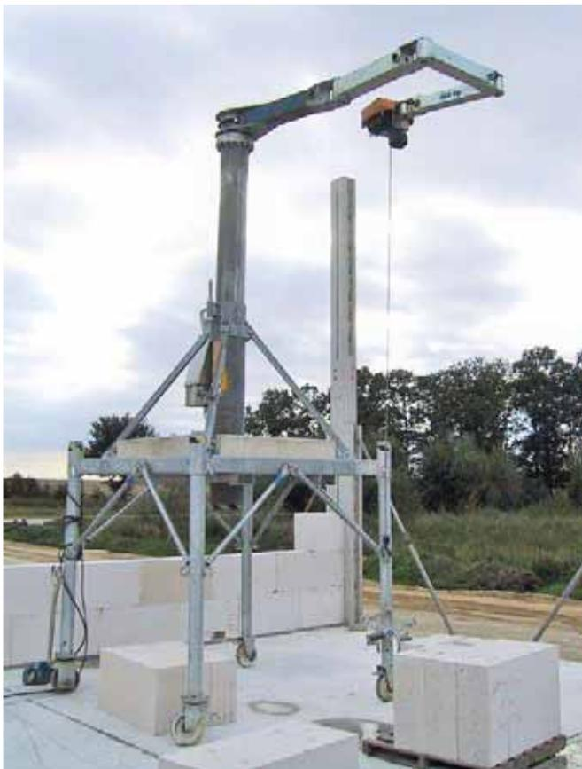
Bild 32 Versetzgerät
