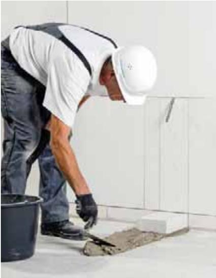
**Bild 33** Mörtel auf die Betonsohle auftragen
