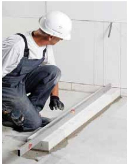
**Bild 36** Kimmsteine in Längsrichtung ausrichten
