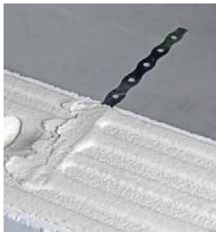
Bild 35 Stumpfstoßtechnik: Mörtelbett mit Edelstahl-Flachanker
