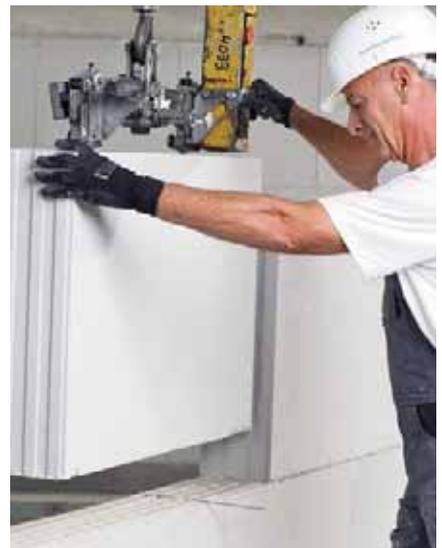
**Bild 42** Versetzen der folgenden Elemente
