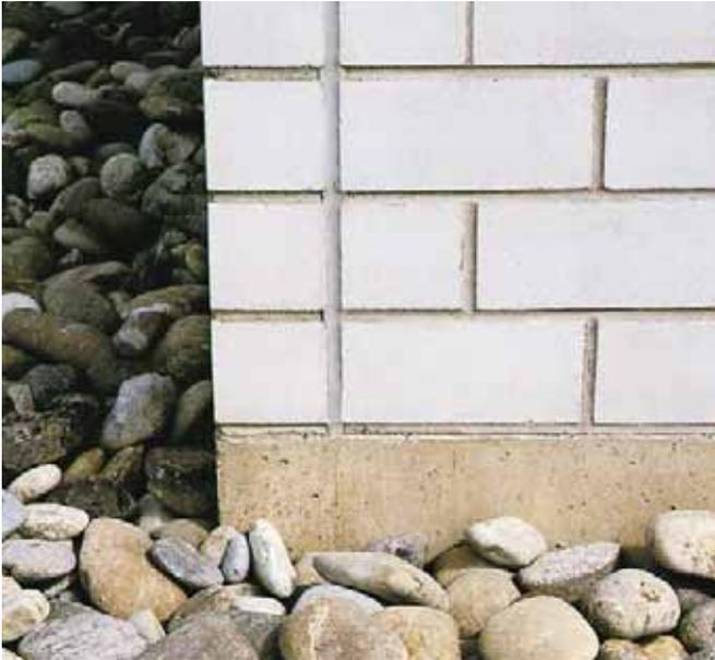
**Bild 11** Ausführung einer Dehnungsfuge an einer Gebäudekante mit spritzbarem Fugendichtstoff
