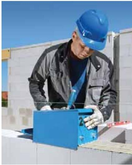
Bild 3 Mörtelauftrag mit Mörtelschlitzen
