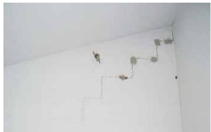
Bild 13 Rissbildung durch Verkürzung eines Stahlbetongurts
