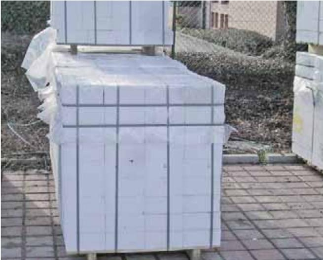
Bild 19 Lagern von Steinen mit Schutz gegen Niederschlag
