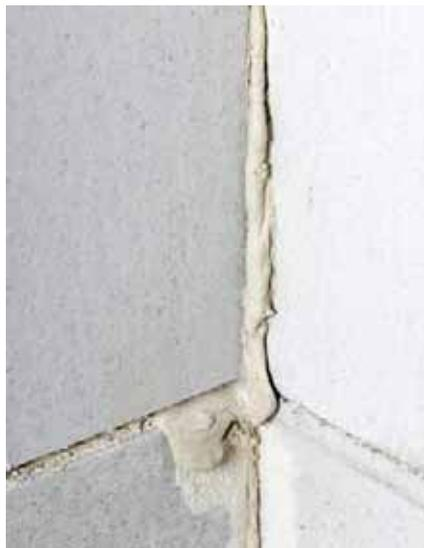
**Bild 41** Vollfugiger Stumpfstoßanschluss mit Dünnbettmörtel vor dem Abstreichen
