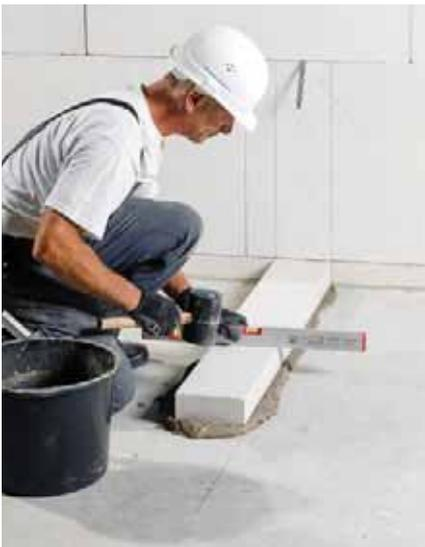
**Bild 35** Kimmsteine in Querrichtung ausrichten
