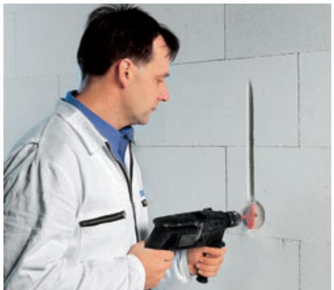
PORIT-Porenbeton lässt sich einfach sägen, schlitzen und bohren
