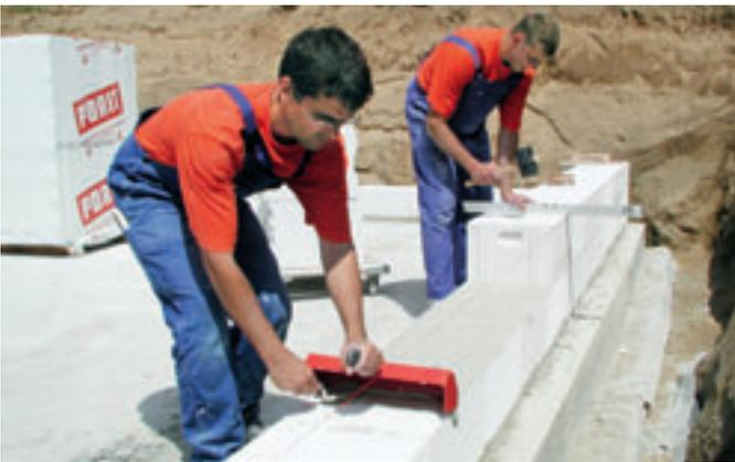
Aufziehen von Dünnbettmörtel und Ausrichtung der Steine
